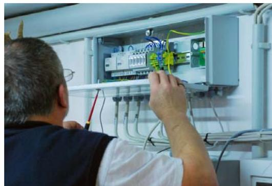
**Bild 2: Inbetriebnahme des Elektrozählerkastens bei einer Wärmepumpenanlage**
