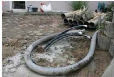
Fünf Leitungen ragen aus dem Boden: zwei Vorläufe, zwei Rückläufe, durch eine wird das Bohrloch verfüllt. Foto: Werner Liesenhoff
