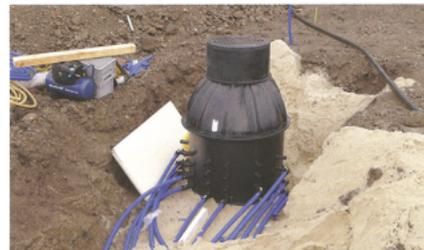
Unter der Bodenplatte des ITS-Gebäudes wird der Verteilerschacht für die EWS-Anlage platziert.
