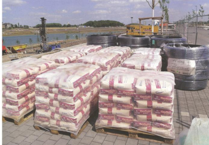
PE-RC-Sonden von Frank und der Verfüllbaustoff GeoSolid 240 HS von Fischer Spezialbaustoffe warten auf ihren Einbau.
