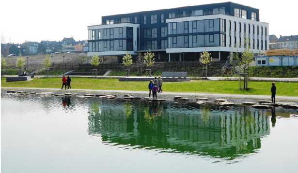
Foto: Fertiggestelltes Gebäude (ERDWÄRME21 GmbH)
