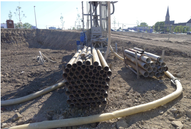
Foto: Bohrgestänge und Schutzrohr (ERDWÄRME21 GmbH)
