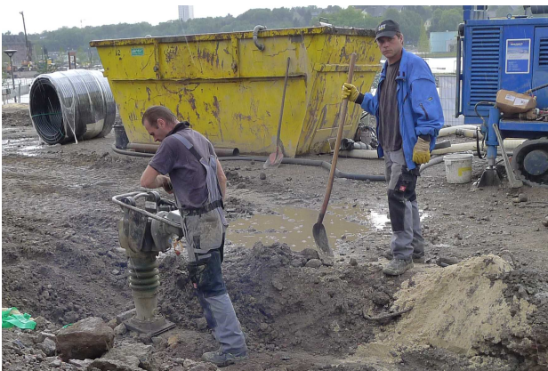
Foto: Verfüllen und Verdichten (ERDWÄRME21 GmbH)
