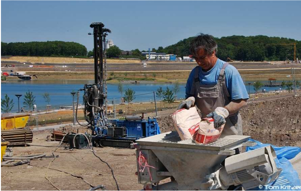
Foto: Verpressen der Sonde (ERDWÄRME21 GmbH)
