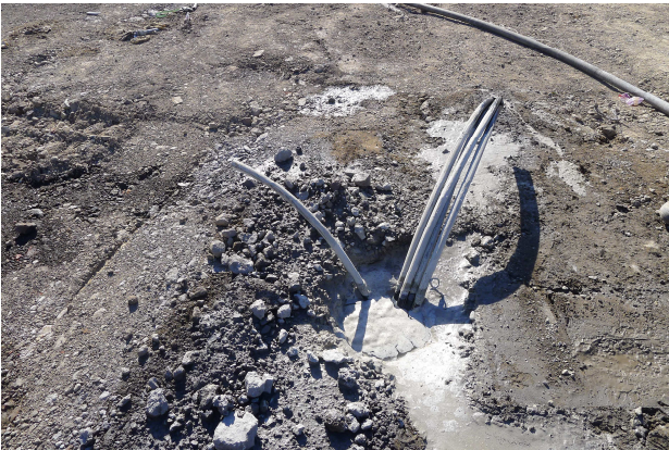
Foto: Fertiggestellte Sonde (ERDWÄRME21 GmbH)
