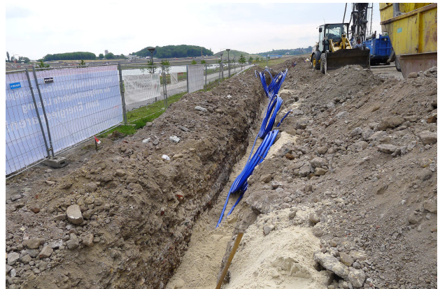
Foto: Verlegung im Sandbett (ERDWÄRME21 GmbH)
