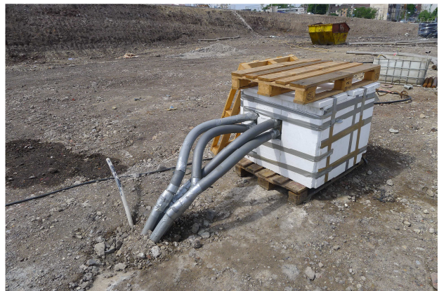
Foto: Thermal Response Test (ERDWÄRME21 GmbH)
