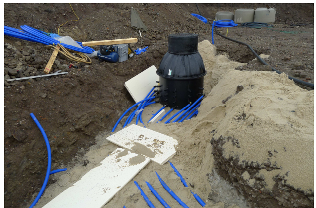
Foto: Isolierungsschicht (ERDWÄRME21 GmbH)
