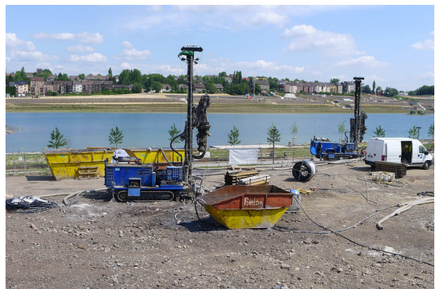
Foto: Bohrarbeiten (ERDWÄRME21 GmbH)
