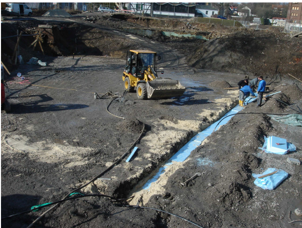
Foto: Verlege- und Isolierarbeiten (ERDWÄRME21 GmbH)
