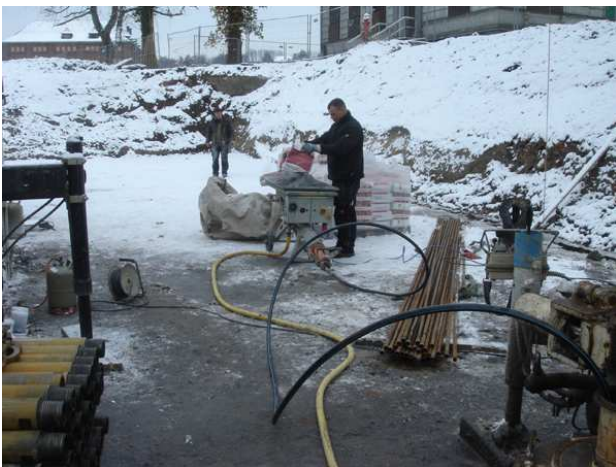
Foto: Verpressen der Sonde (ERDWÄRME21 GmbH)
