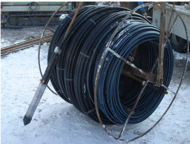
Foto: Doppel-U-Sonde (ERDWÄRME21 GmbH)
