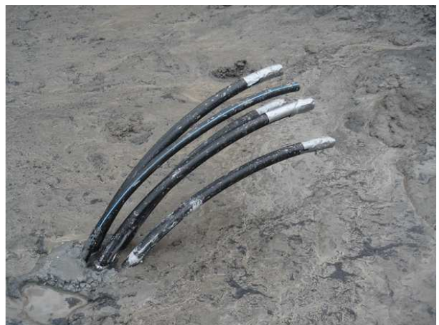
Foto: Fertiggestellte Sonde (ERDWÄRME21 GmbH)
