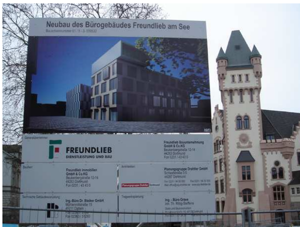
Foto: Bauschild an der Hörder Burg (ERDWÄRME21 GmbH)
