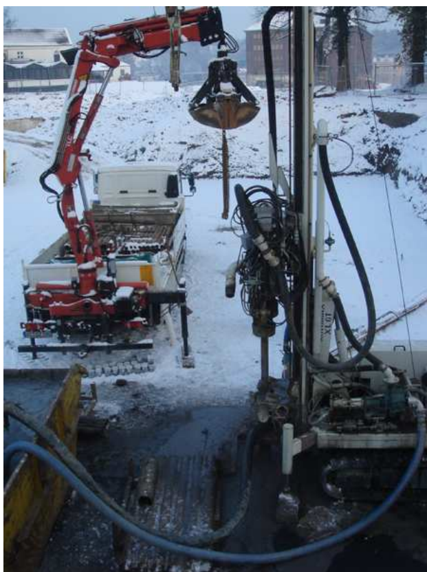
Foto: Bohrarbeiten (ERDWÄRME21 GmbH)
