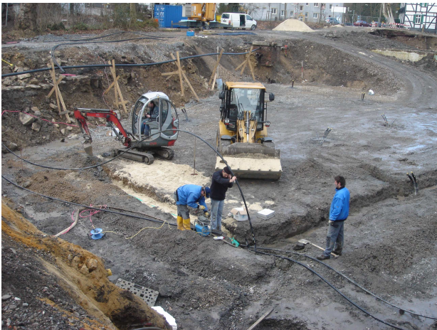
Foto: Anbindeteam (ERDWÄRME21 GmbH)
