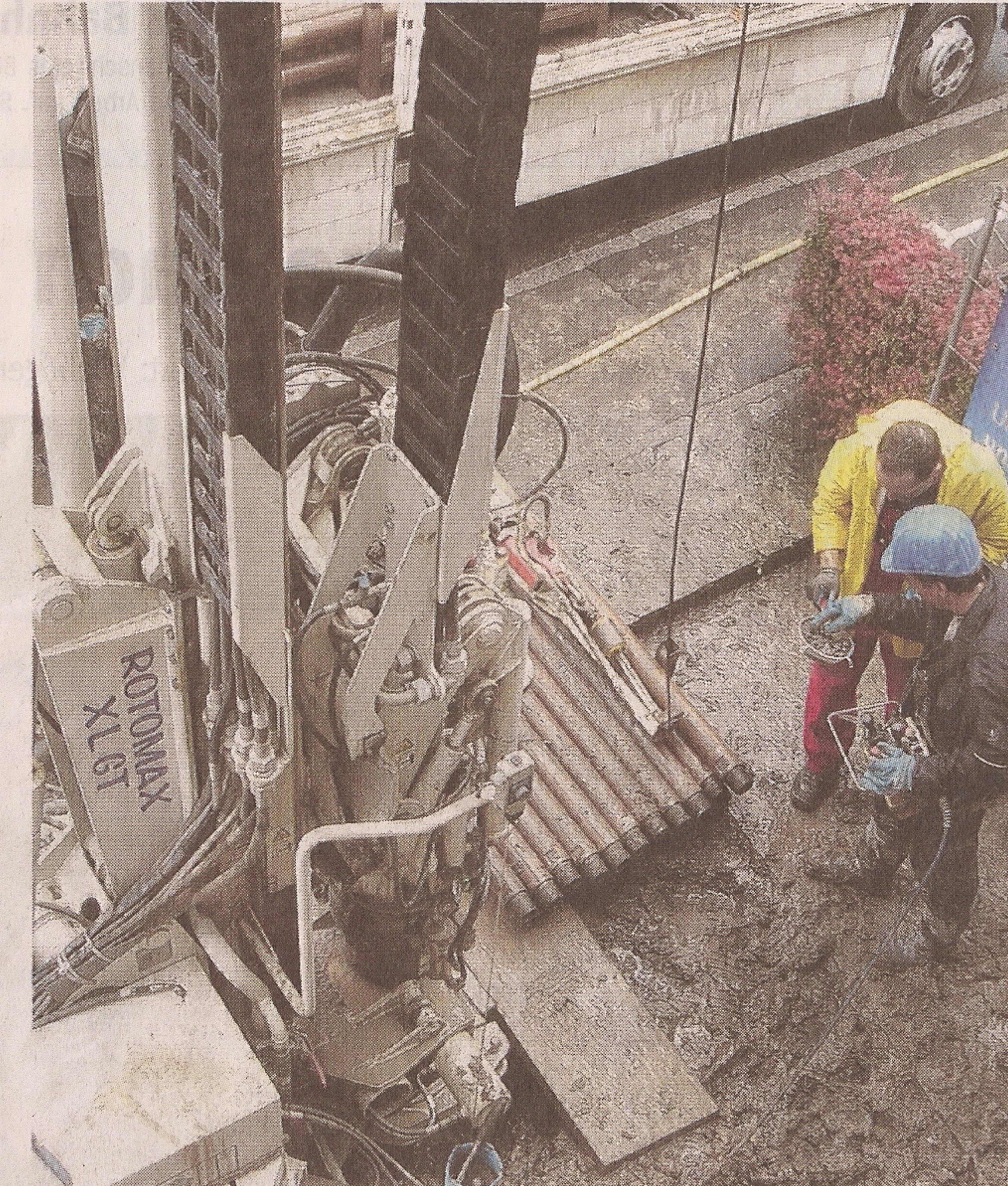
Immer tiefer, immer tiefer: Fast 100 Meter dreht die Bohrmaschine die schweren Bohrstangen in die Erde vor dem Mehrfamilienhaus „Im Wullen“.
